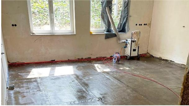
Im Baueinsatz am letzten Samstag sind die Kellerräume nun komplett leerräumt und gereinigt worden. Damit gehen wir zum Wiederaufbau über und starten mit den ersten handwerklichen Maßnahmen. Dazu gehören Ausbesserungen an den Wänden (Trockenbau), Reparaturen an den Schweißbahnen und Arbeiten im Sanitärbereich. Wäh-
